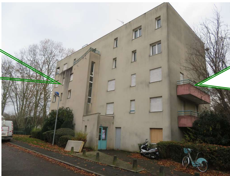
Désintox: Ce bâtiment, plus récent, n'est même pas amianté
