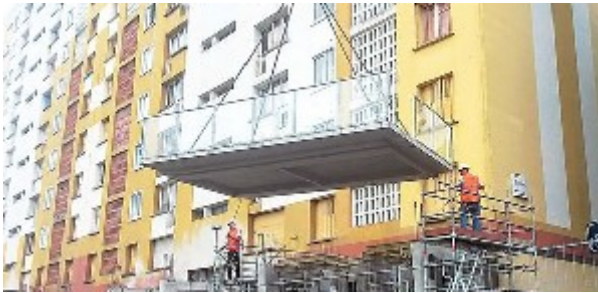
Photo du chantier Grand Pars à Bordeaux citée dans le texte
