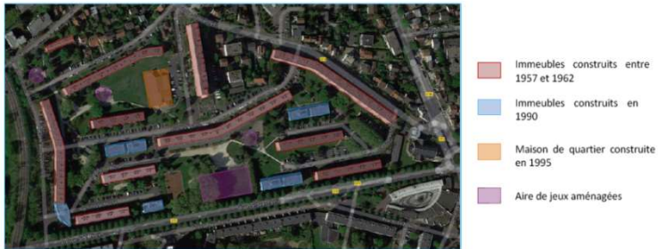
Quartier des Paradis – Identification des constructions
