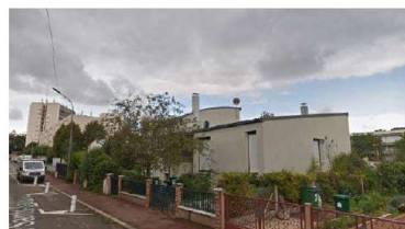
Exemple de pavillons en secteur UC - Rue des Saints-Sauveurs
