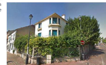
Potentiel de densification en centre-ville - Maison avec un terrain de 500 m² - avenue de Verdun
