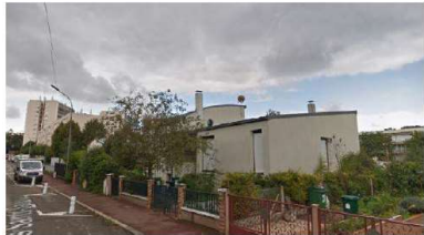
Exemple de pavillons en secteur UC - Rue des Saints-Sauveurs
